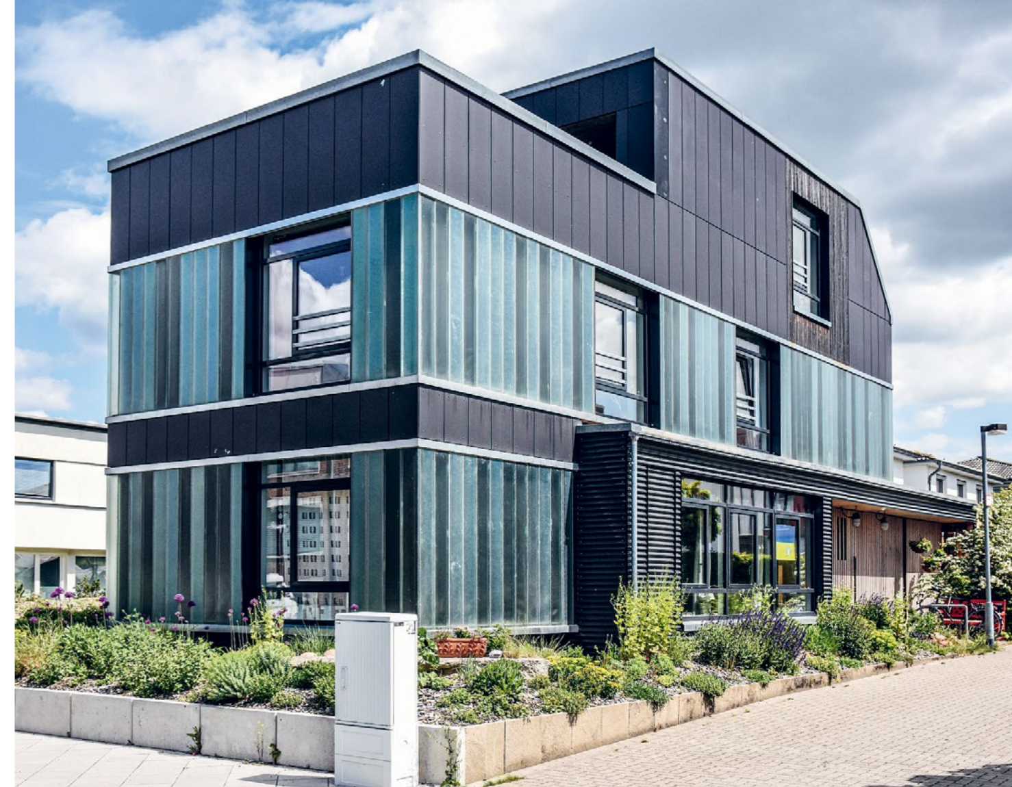
Die Glaselemente der Fassade stammen aus einer abgerissenen Lackiererei, die Verkleidung rechts besteht aus Brettern von Saunabänken.
