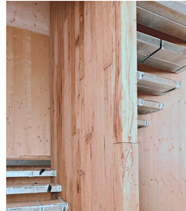
Die Mittelwand der Treppe ist aus alten Eichenbalken verschraubt.
